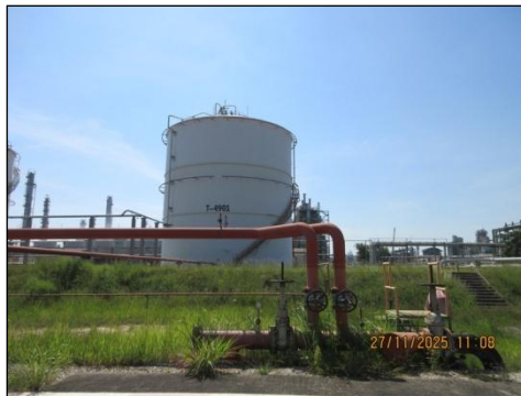
รูปที่ 3-23 ระบบเชื่อมต่อระดับเพลิงของหน่วยผลิตไฟฟ้า EPS และโรงผลิตสารโอเลฟินส์ สาขานนไเอ-หนึ่ง
