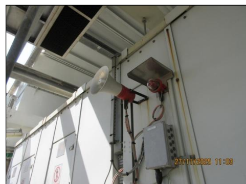
รูปที่ 3-26 Acoustic Alarm System
