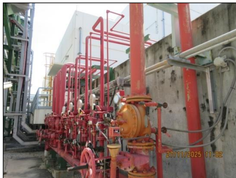
Deluge System บริเวณหม้อแปลงไฟฟ้า
