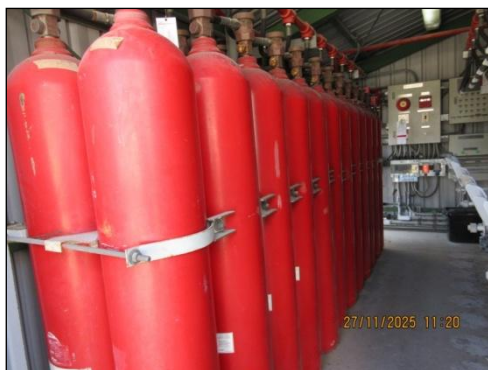
รูปที่ 3-40 Extinguisher Discharge System
