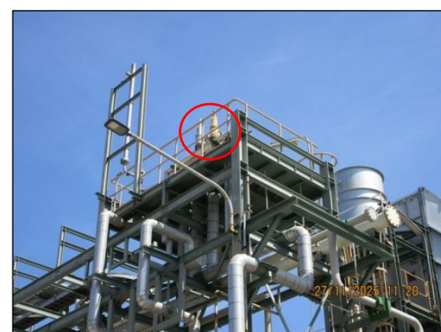
รูปที่ 3-43 Pressure Relief Valve
