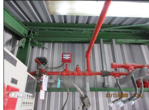
รูปที่ 3-39 Solenoid Valve CO 2
