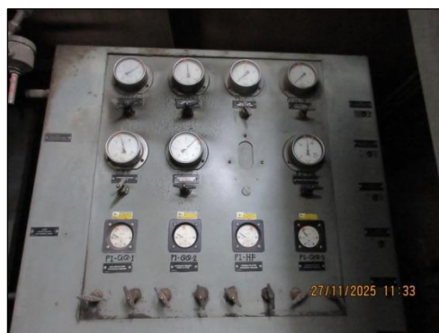
รูปที่ 3-42 ระบบ Pressure Monitoring
